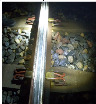
rail après meulage
